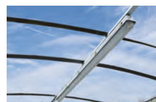
Innenbeleuchtung Wetterfeste Ausführung mit 58 Watt Leuchtkörper.
